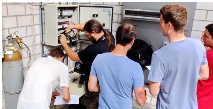
3. Prüfen der elektrischen Ausrüstung einer Anlage
