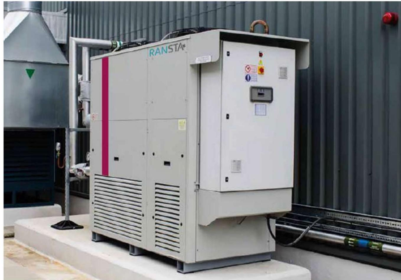
Abbildung 1.1.4: Kaltwassersatz mit Propan (Vertrieb durch TEKO, Typ RANSTA)
