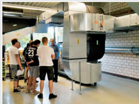
Und Herr Otto führte mit seinen Gruppen an einer raumlufftechnischen Anlage die Erfassung der Luftvolumenströme im Kanalsystem mit Messung von Lufttemperatur, Feuchte und Geschwindigkeit durch.
