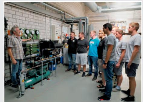
Herr Bamberger und Herr Dr. Lampert führten mit ihren Gruppen an der 2-stufigen R407F-Kälteanlage Leistungsmessung mit und ohne Flüssigkeitsunterkühlung durch.
